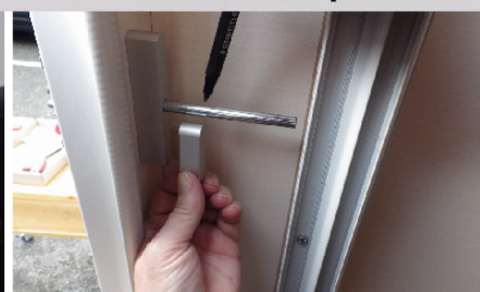
14 - Pignon en Appuis sur le Ressort Tracez & coupez la tige du Pignon
