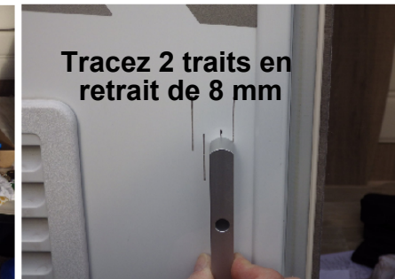
5 - et Déterminez la zone de perçage
