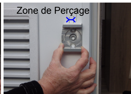
7 - Ici Fixation Directement sur le Panneau
