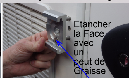
12 - Enfilez les Vis puis la Calle Blanche (si Utilisée)
