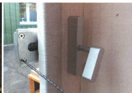
17 - Montez & Bloquez la Manette (Fermé en Bas) puis Enfilez la Toile Inox & monter les 2 Vis FHC-M4
