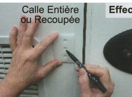
11 - Tracez et Percez 3 Trous Ø 9
