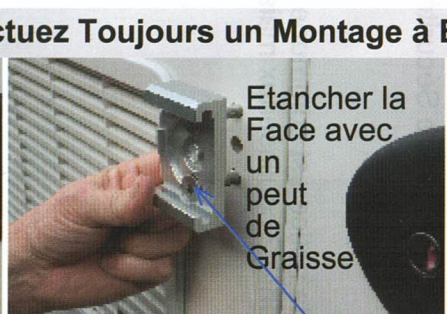
12 - Enfilez les Vis puis la Calle Blanche (si Utilisée)
