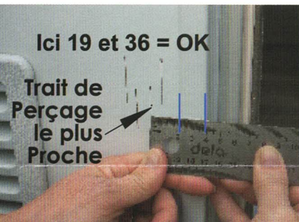
6 - Mesure des Cotes Mini de 5 et 22 mm (voir au dos)
