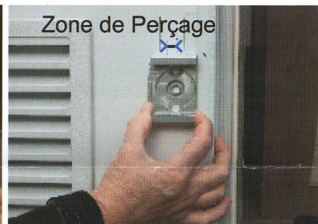
7 - Ici Fixation Directement sur le Panneau
