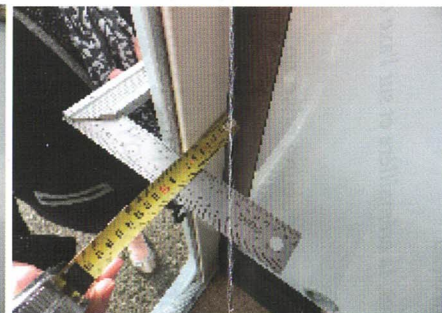
3 - Mesure de la Cote Mini - Ici 62
