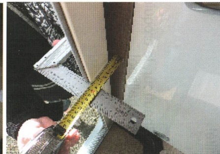
2 - Mesure de la Cote Maxi - Ici 87
